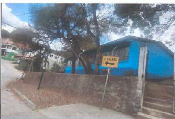
Foto 4: Se realizará el cambio de malla a todo el perímetro del edificio escolar.
