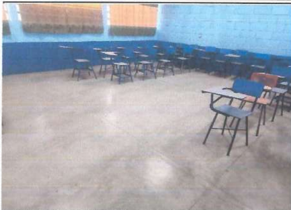
Foto 1: Se le colocará piso cerámico a este salón de clase
